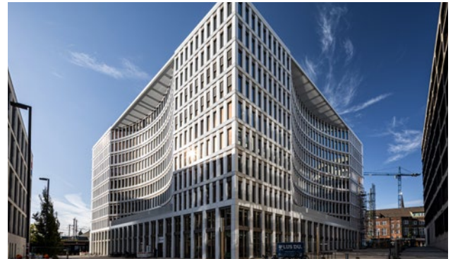
Hamburg, Büro, Neubau, 114 Mio. Euro
